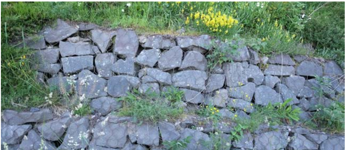
Murets de pierre (gabion) en travers de la pente pour freiner l'écoulement des eaux.
