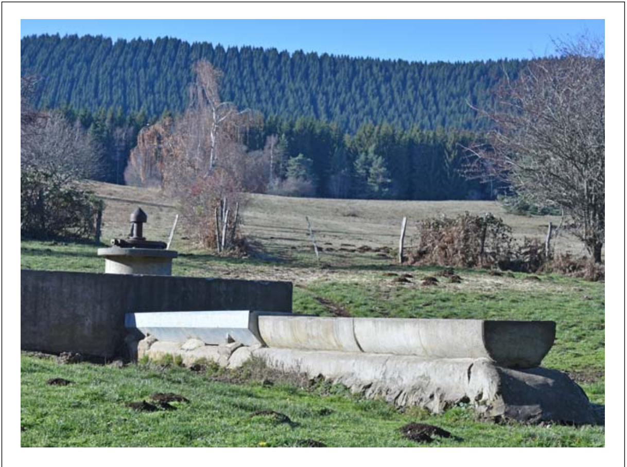
Abreuvoir alimenté par un captage sur une source : les Communaux de Beaune-le-Chaud.
