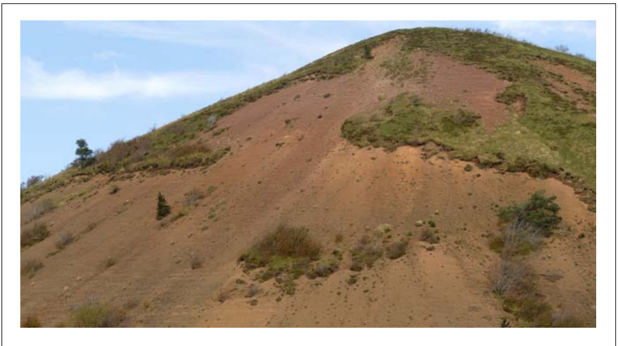
Détail de la pente érodée.
