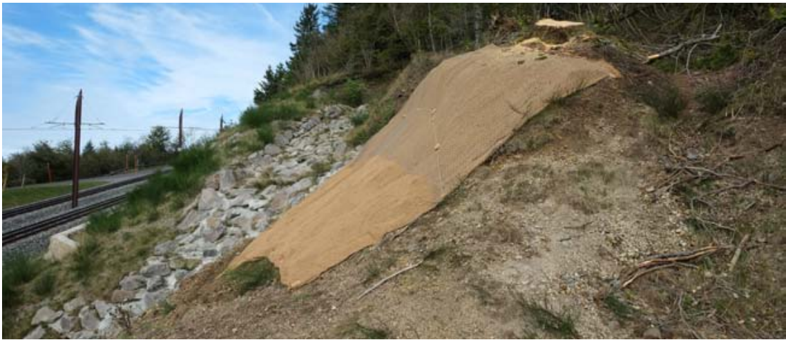
Plaque de coco fraîchement installée le long du Sentier des Muletiers posée comme un « sparadrap » sur une zone érodée.
