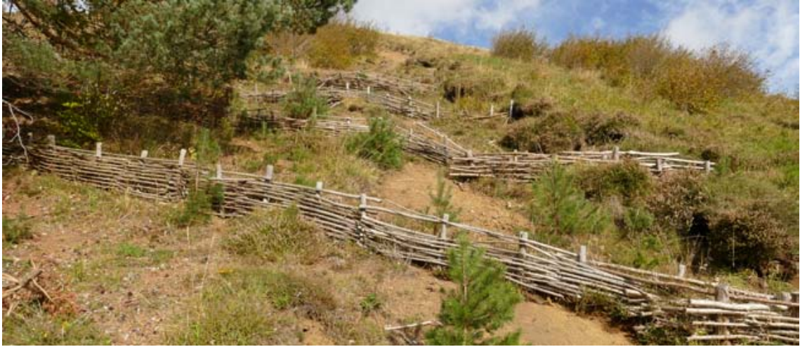
Seuils de fascines en travers d'une pente érodée.
