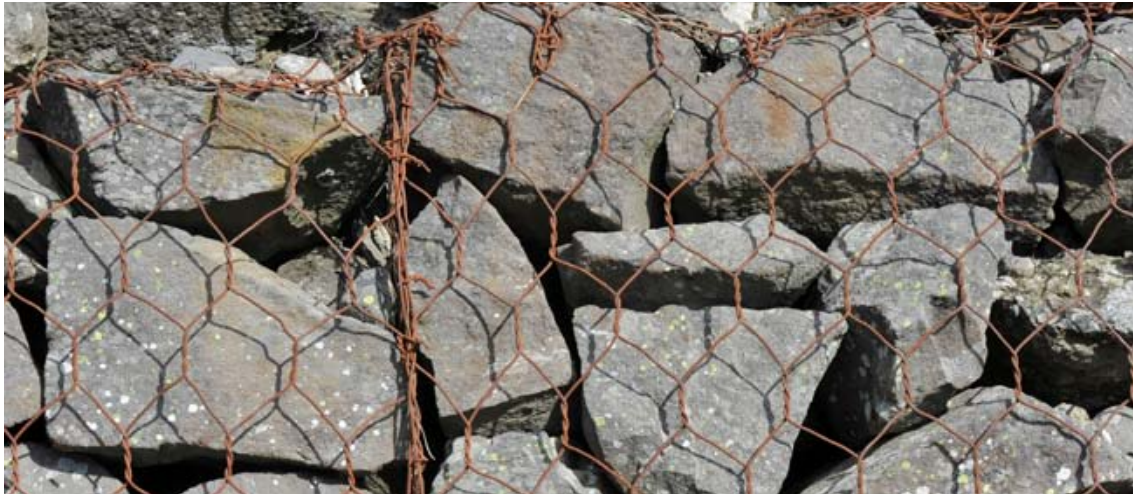
Détail du muret enveloppé de grillage ; ces murets servent de plus d'abris pour la faune (insectes, lézards et serpents...).
