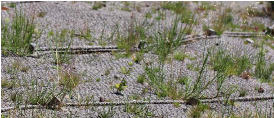
Filet de coco maintenu par des piquets et permettant une recolonisation rapide de la végétation tout en protégeant le sol du ruissellement.
