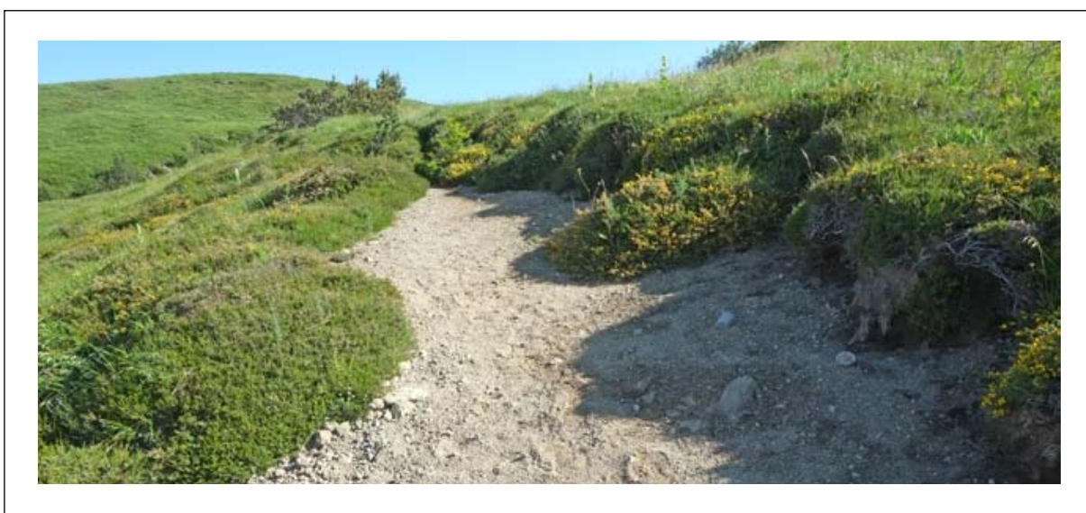
Le sentier connaît une très forte fréquentation et l'érosion liée au piétinement gagne progressivement sur les talus en bordure.
